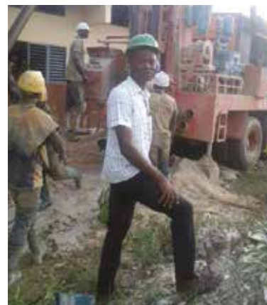
Suivi des travaux de foration par le chargé Eau de la mairie de Natitingou.
