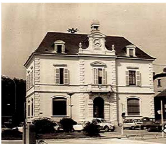
La mairie place de Verdun. Aujourd'hui, la médiathèque et les Archives s'y sont installées de manière provisoire
