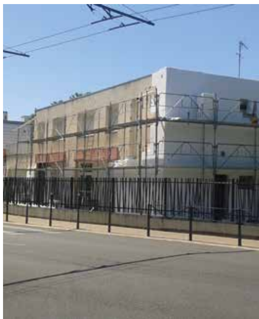
Travaux d'isolation par l'extérieur réalisés au groupe scolaire des Alagniers (Maternelle B) - Avant et après
